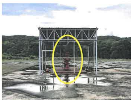
รูปที่ 2-41 ติดตั้งระบบบวสว (Christmas Tree) โดยรอบปากหลุม
