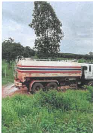
รูปที่ 2-4 การฉีดพรมน้ำบนถนนที่ไม่ได้ลาดยาง
