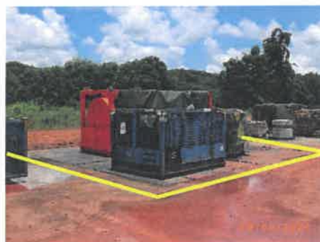
รูปที่ 2-24 ปูผ้าใบในบริเวณที่มีโอกาสปนเปื้อน
