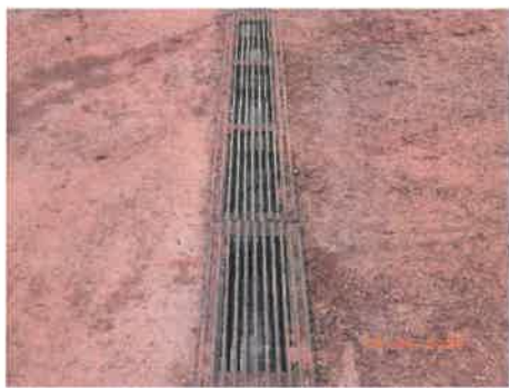
รูปที่ 2-38 รางระบายน้ำรอบฐานคอนกรีต และบ่อเก็บน้ำปนเปื้อน (Dirty water pit)
