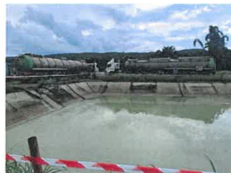
รูปที่ 2-46 การสูบน้ำออกจากบ่อเก็บน้ำปนเปื้อน (Dirty water pit) ไปกำจัด
